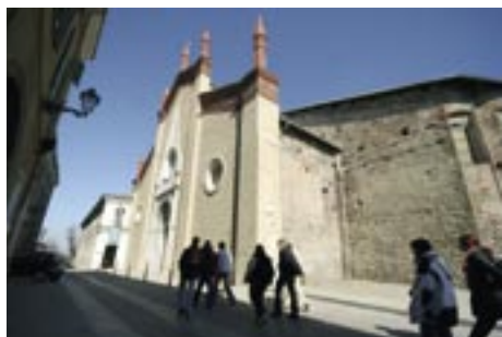
Complesso monumentale di San Francesco, Cuneo
