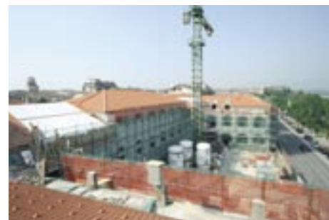
Cantiere nuova sede università; ex ospedale S.Croce, Cuneo
