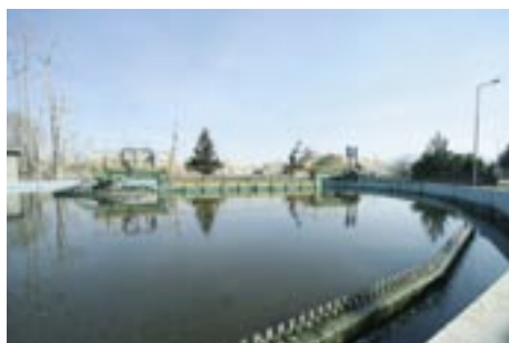
Impianti di depurazione acque reflue, Cuneo
